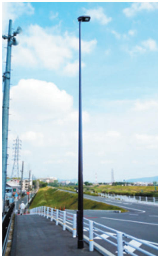
2 大阪府 利倉橋照明(2021年)
