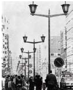
銀座通りを彩る 丸一の角パイプ (ガス灯タイプの 街路灯・交通 信号機)
