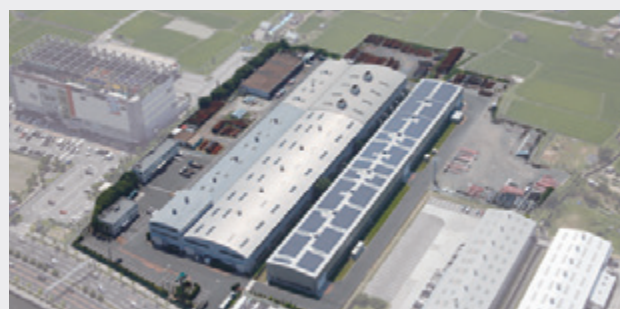
堺特品工場 Sakai Pole Plant **
