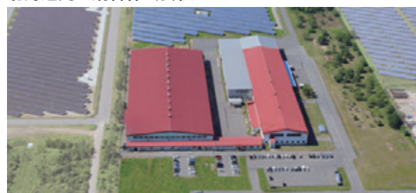
苫小牧工場 Tomakomai Plant **
