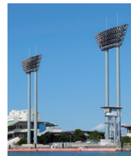
照明鉄塔 Lighting Tower
