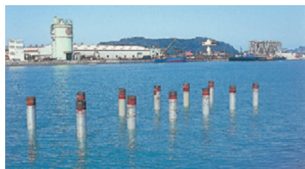
鋼管ぐい Pipe Piling
