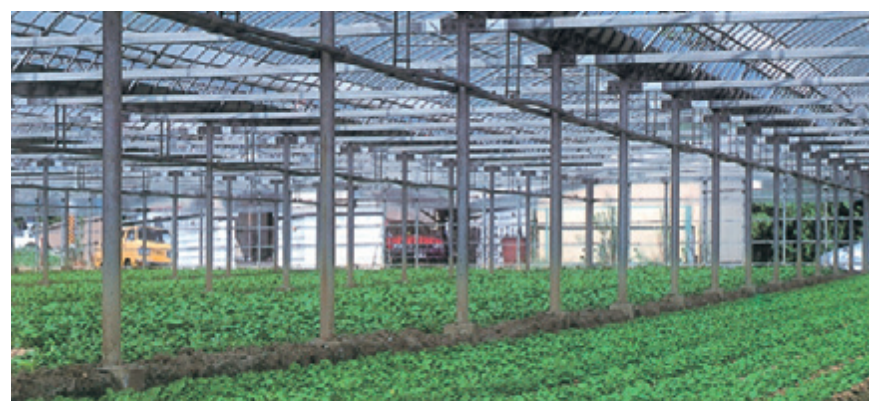
大型ハウス Green House Framing
