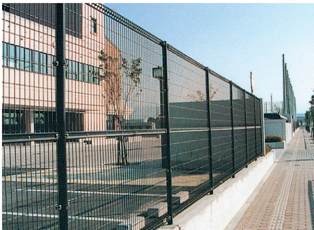
フェンス支柱
