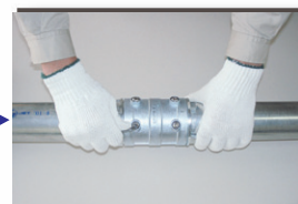
締め付けボルトで固定する
