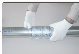
締め付けナットをしめる
