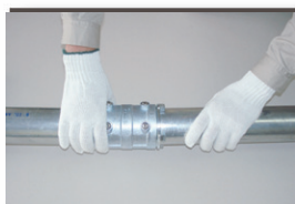
管を差し込む
